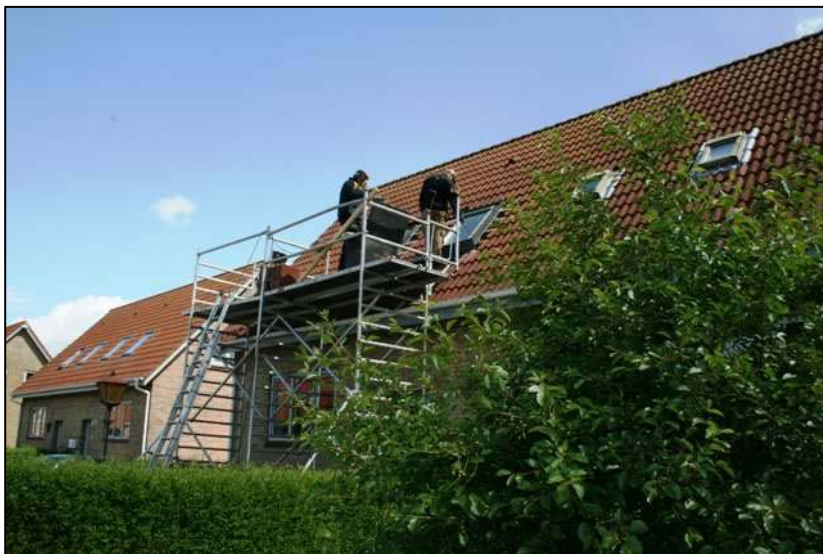
Håndværkerne arbejder i højden på Lavbrinkevej – afdeling 23
